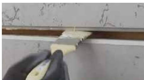
Exemple d'utilisation de la colle FO142 avec le bourrelet FJ203 Altofeu et le silicone FS703.
