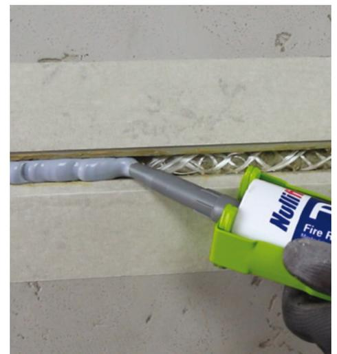
Fuge kann anschliessend je nach Wunsch mit einem geeigneten Dichtstoff (z. B. Nullifire FS702, FS703 oder illbruck SP520, FA880) versiegelt werden.
